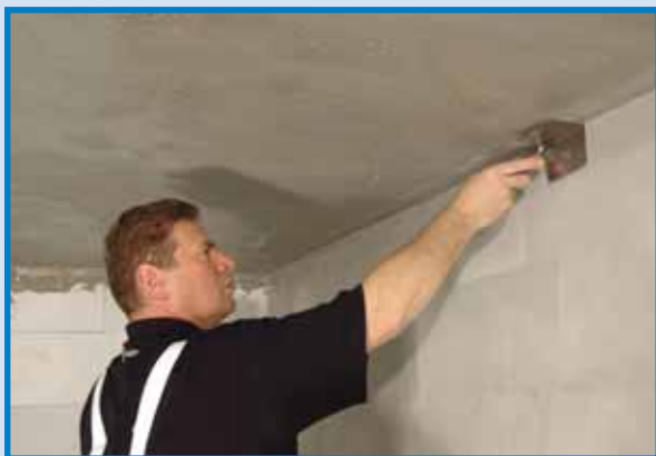
6. Vnúťorné kúty miestnosti sa zapravujú pomocou rohového hladítka.
