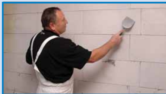
3. Špachtľou zrazíme zvyšky stavebného lepidla alebo murovacej malty.
