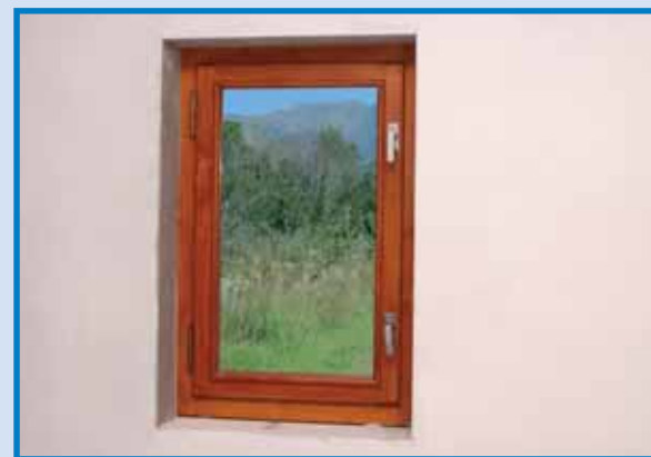
4. Vďaka hladkosti stierok Rimano nie je ani dodatočná oprava ostenia vôbec potrebná.
