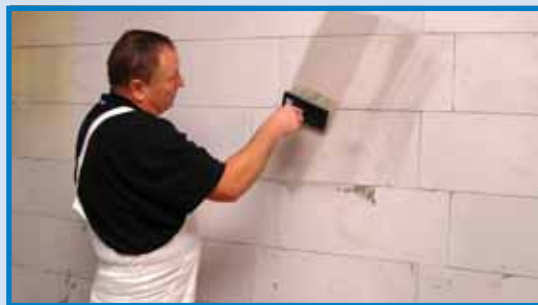
4. Štetkou namočenou v čistej vode zistíme savosť podkladu.
