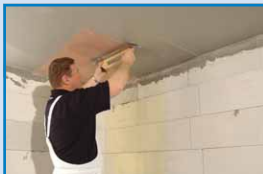
1. Aplikácia Rimana na betónový strop opatrený s kontaktným náterom.
