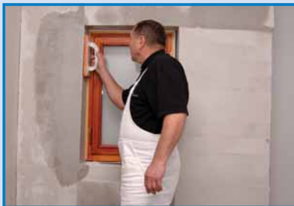
3. Po zavädnutí nanesej stierky sa povrch roztočí navlhčenou penovou hubkou. V prípade, že sú zostávajúce plochy hladké, vykoná sa finálne vyhladenie povrchu špachtľou alebo hranou hladítka.
