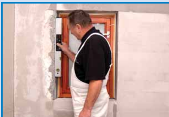
1. Najskôr sa osadí ochranný rohový profil do sadrových terčov a vyrovná sa vodováhou voči rámu okna. Osadenie APU lišty na rám okna/dverí uľahčí začistenie ostenia a pružne oddelí rám od omietky. Tým sa eliminuje vznik trhlín v mieste styku rámu a omietky.
