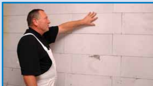
2. Dotykom dlane prekontrolujeme kvalitu podkladu – premrznutie, súdržnosť a pod.
