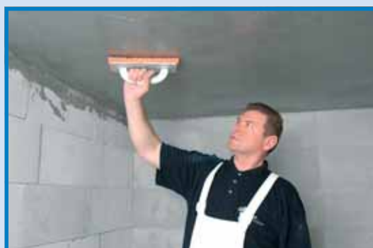
4. Po zavädnutí sa povrch roztočí navlhčeným penovým hladítkom.
